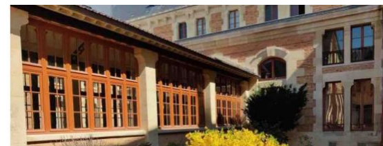
La galerie du bâtiment administratif
